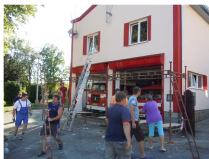
rekonstr. hasič. zbrojnice - dobrov.práce
